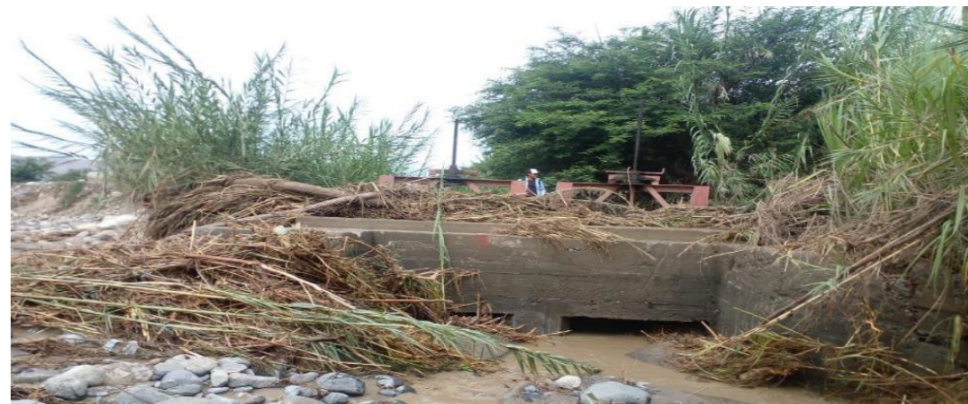
FIGURA N°02: INFRAESTRUCTURA HIDRAULICA AFECTADA POR LAS CRECIDAS DEL RIO NEPEÑA, EN SU MARGEN IZQUIERDA.
